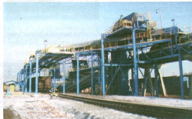
Pohľad na komplex s dopravníkmi a násypníkom.
