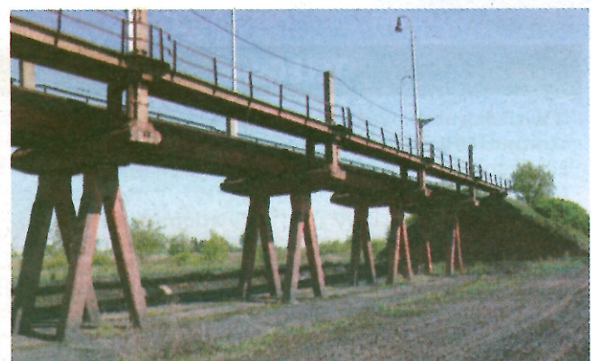
Pohľad na vysokú rampu pred výstavbou technológie rotačného výklopníka.
