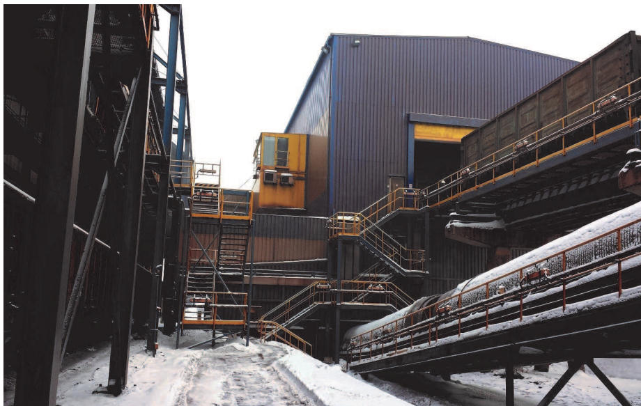
Príama prekládka substrátu v Prekládkovom komplexe - Západ. Vpravo hore prichádza vozeň ŠR na výklopník. Železorzudný substrát putuje dopravníkmi priamo do vozňov rozchodu 1435 mm vľavo dole.
