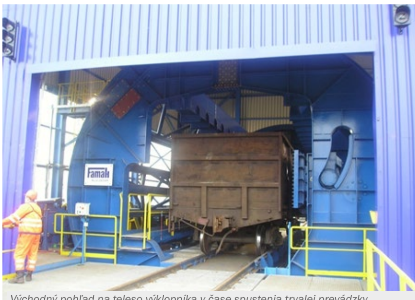
Východný pohľad na teleso výklopníka v čase spustenia trvalej prevádzky.
