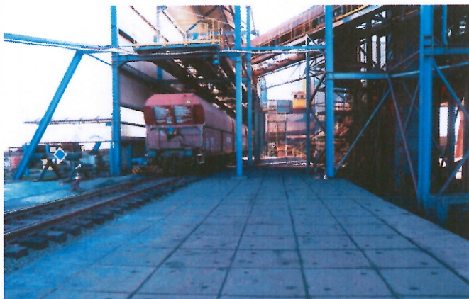
Vlani BTS upravila prístupové komunikácie z južnej a severnej strany technologických zariadení komplexu.
