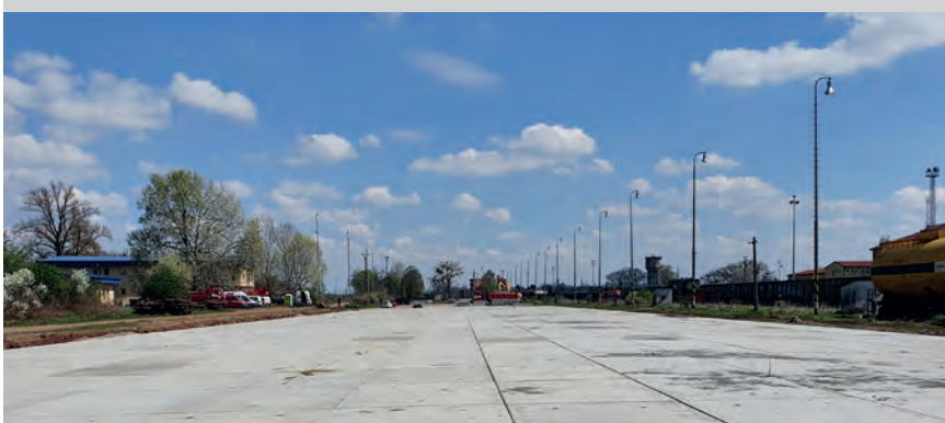
Ukončená prvá etapa stavby panelovej skladovacej plochy.
