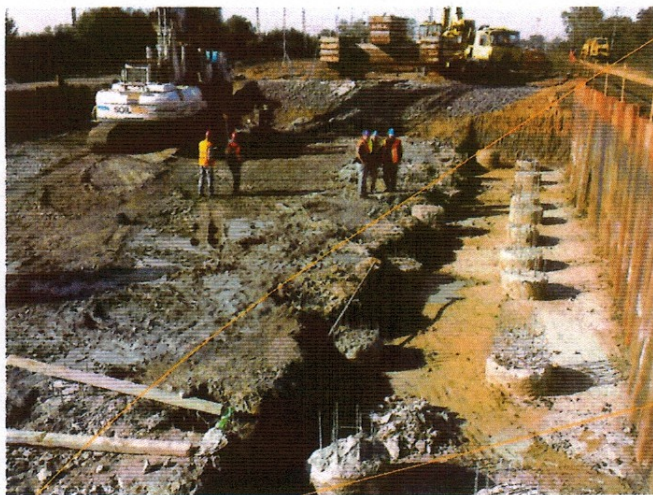
Pilotáž objektu budovy výklopníka v septembri tohto roka. Tipper building pilot view (September 2015).
