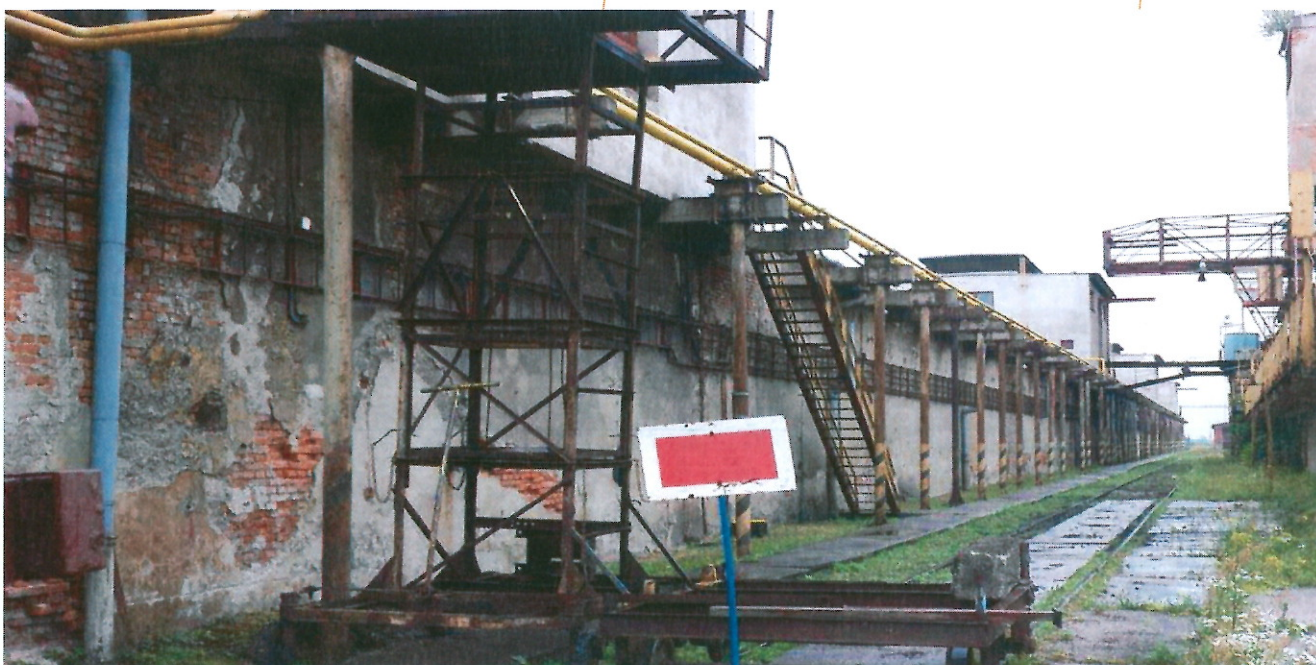
Pohľad na II. Rozmrazovňu pred rekonštrukciou. View of the thawing hall II before reconstruction.
