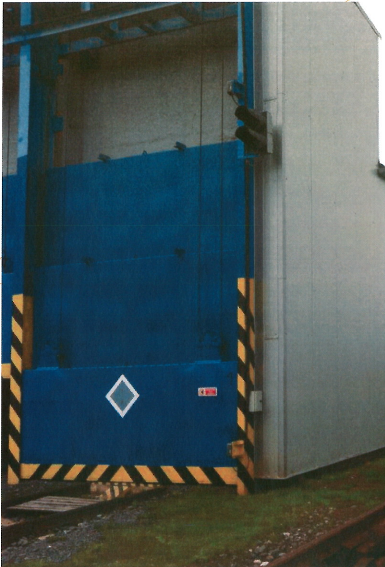
III. Rozmrazovňa bola zrekonštruovaná v roku 2010. The thawing hall III was reconstructed in 2010.
