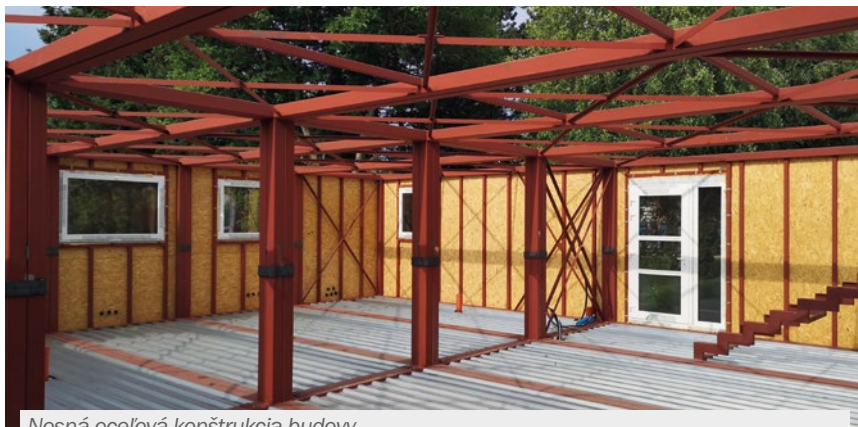
Nosná oceľová konštrukcia budovy.
