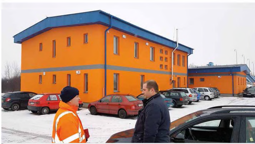
Člen predstavenstva spoločnosti BTS Marian Frko a vedúci pracoviska Východná rampa – Portál Alexander Šohajda pred zrekonštruovanou budovou.
